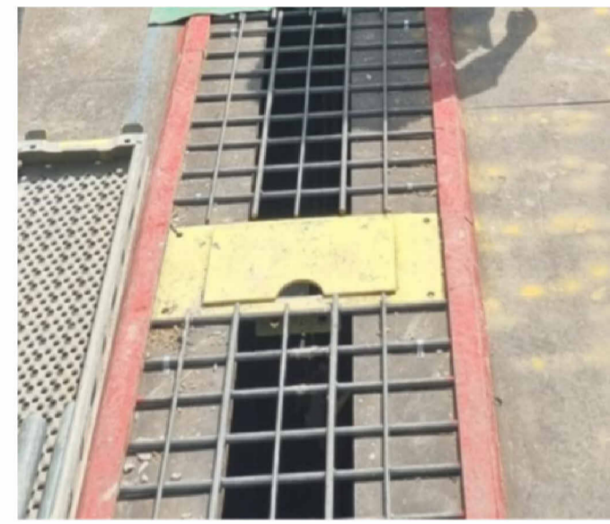
CONCRETE POURING HATCHES
